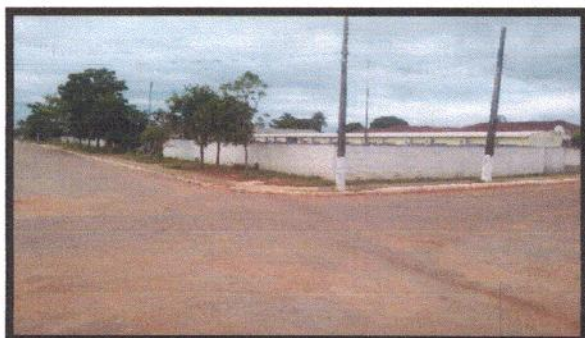
Foto 01: vista da Fachada da Escola área a ser construída.
